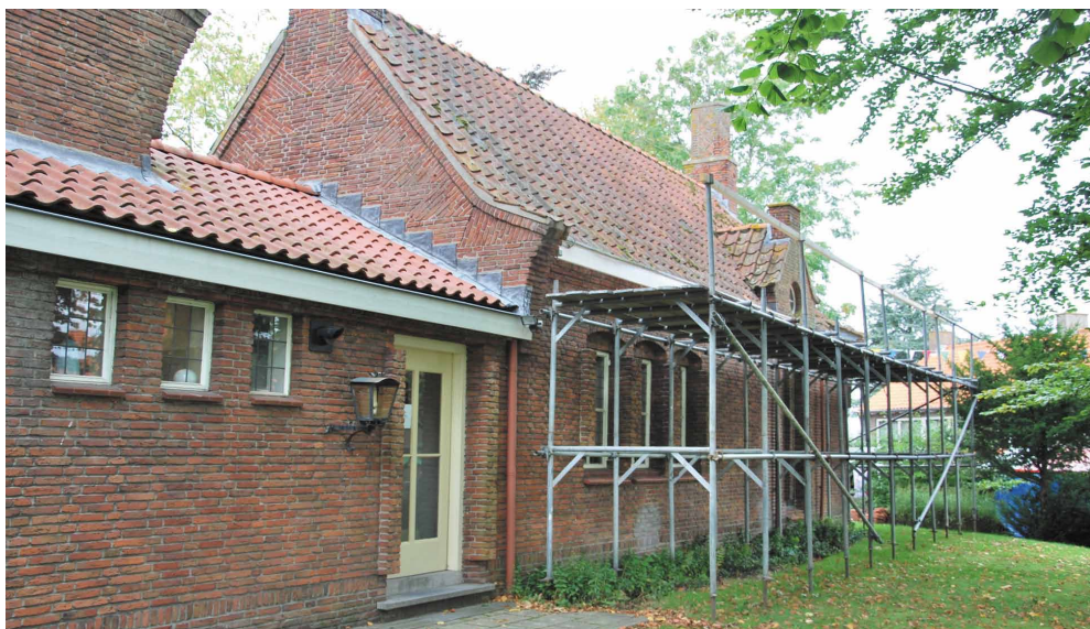
In 2011 is het dak van de consistorie in Schore grondig gerenoveerd.
